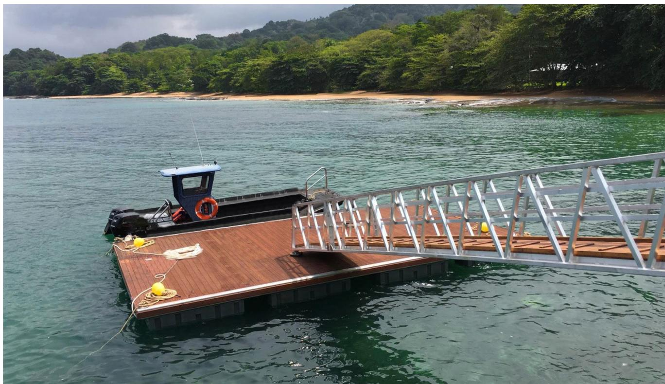
Los sistemas Faro y Faro+ están formados por pantalanés flotantes con una estructura con perfil especial de aleación de aluminio compuesto por unidades modulares.
