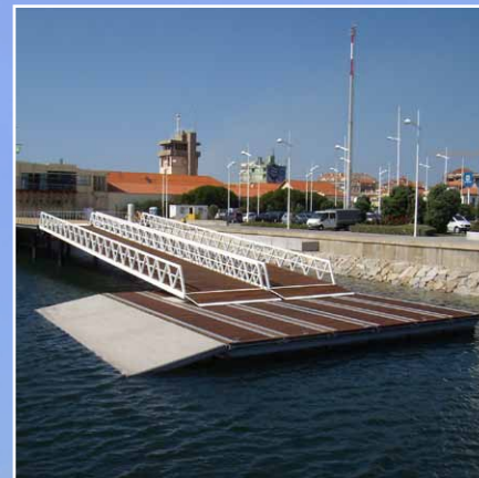
Rampas y Pasarelas de Acceso
