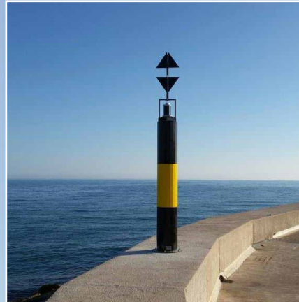
Postes y Torres
