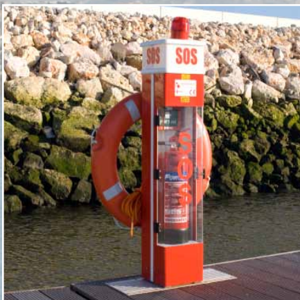
Torretas de Emergencia
