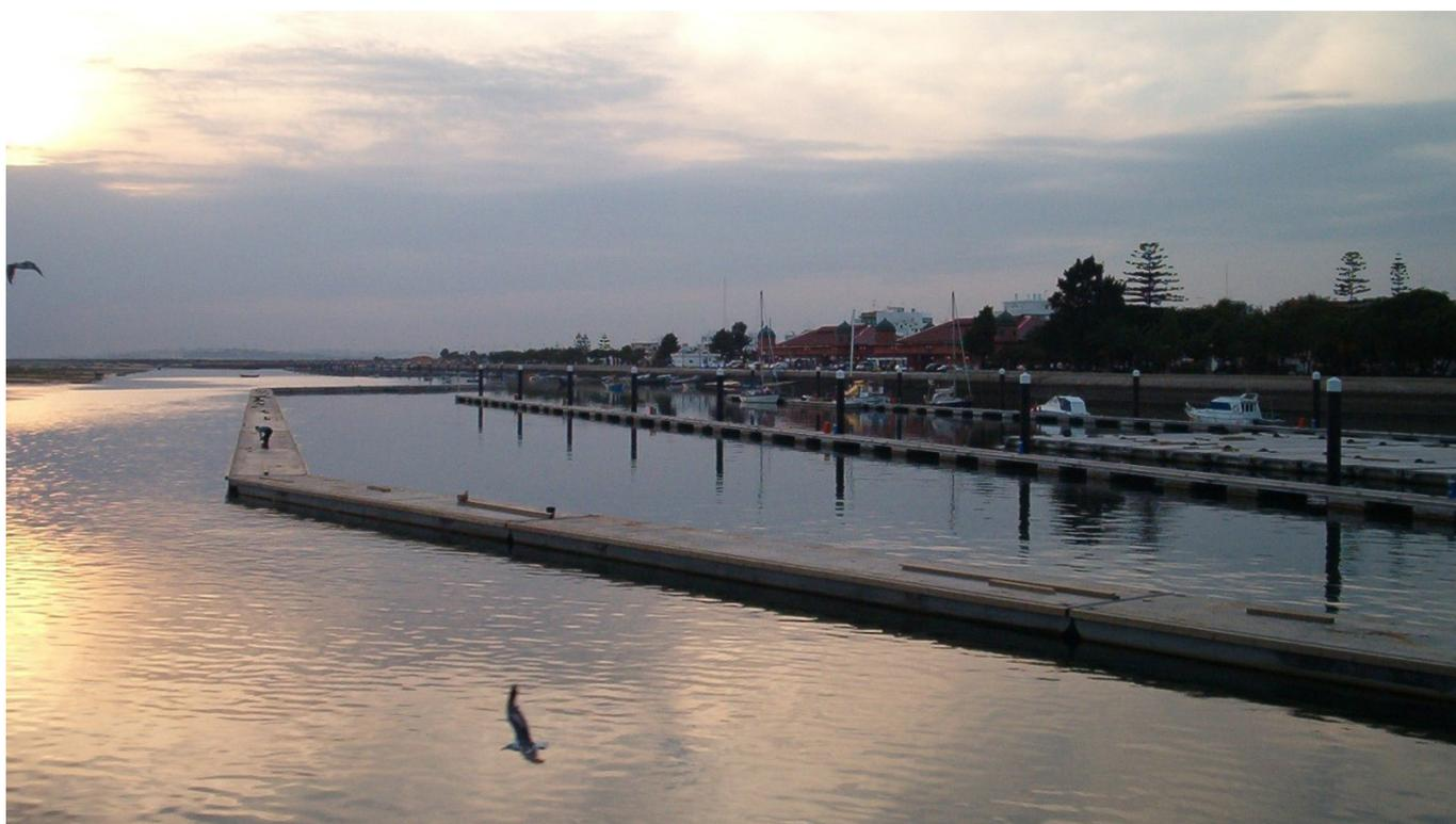
La gama QMF (Rompeolas Flotantes) está formada por pantalanés robustos, resistentes y seguros de hormigón reforzado con núcleo de poliestireno expandido.
