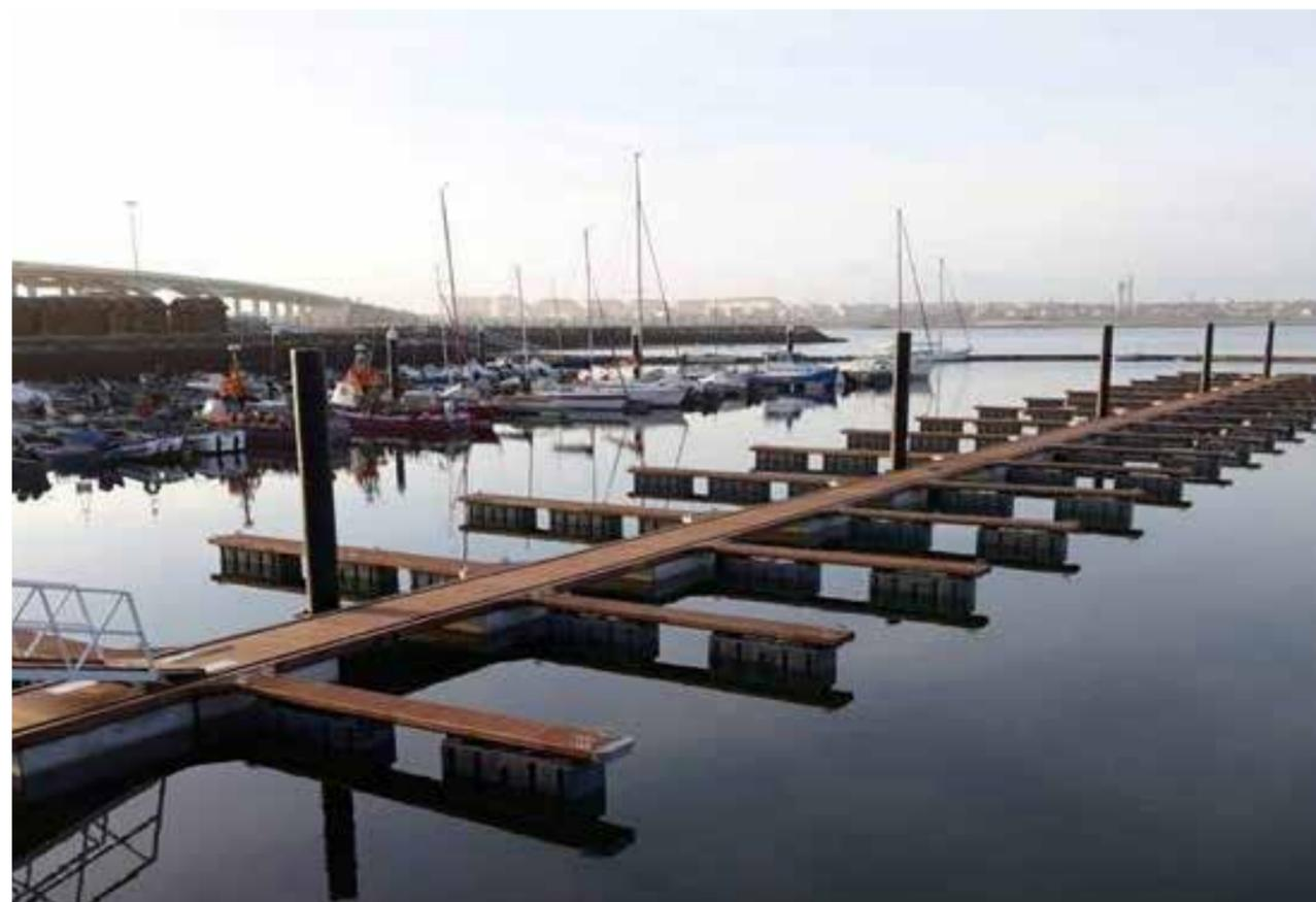
Los sistemas Sagres y Sagres+ están formados por pantalanes flotantes con estructura de acero galvanizado por inmersión en caliente, compuesto por unidades modulares y adecuados a condiciones meteorológicas exigentes; opcionalmente, y sujeto a las características específicas de cada aplicación, las estructuras pueden ser pintadas después de la galvanización. Los pantalanes se suministran con
