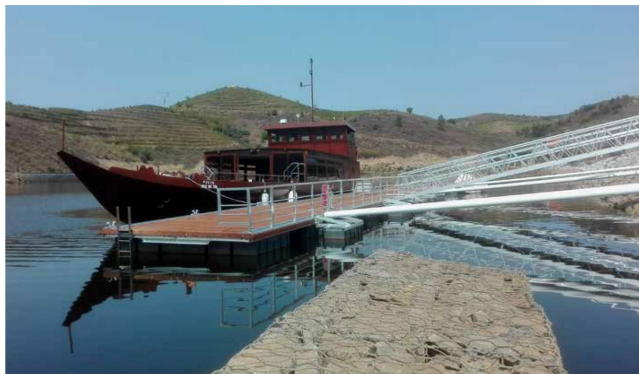
El sistema Faro HD está formado por equipamiento flotante con estructura reforzada con aleación de aluminio marítimo. Se utiliza para el amarre de embarcaciones en dársenas semiprotegidas en zonas agresivas donde la corrosión es un factor crítico.
