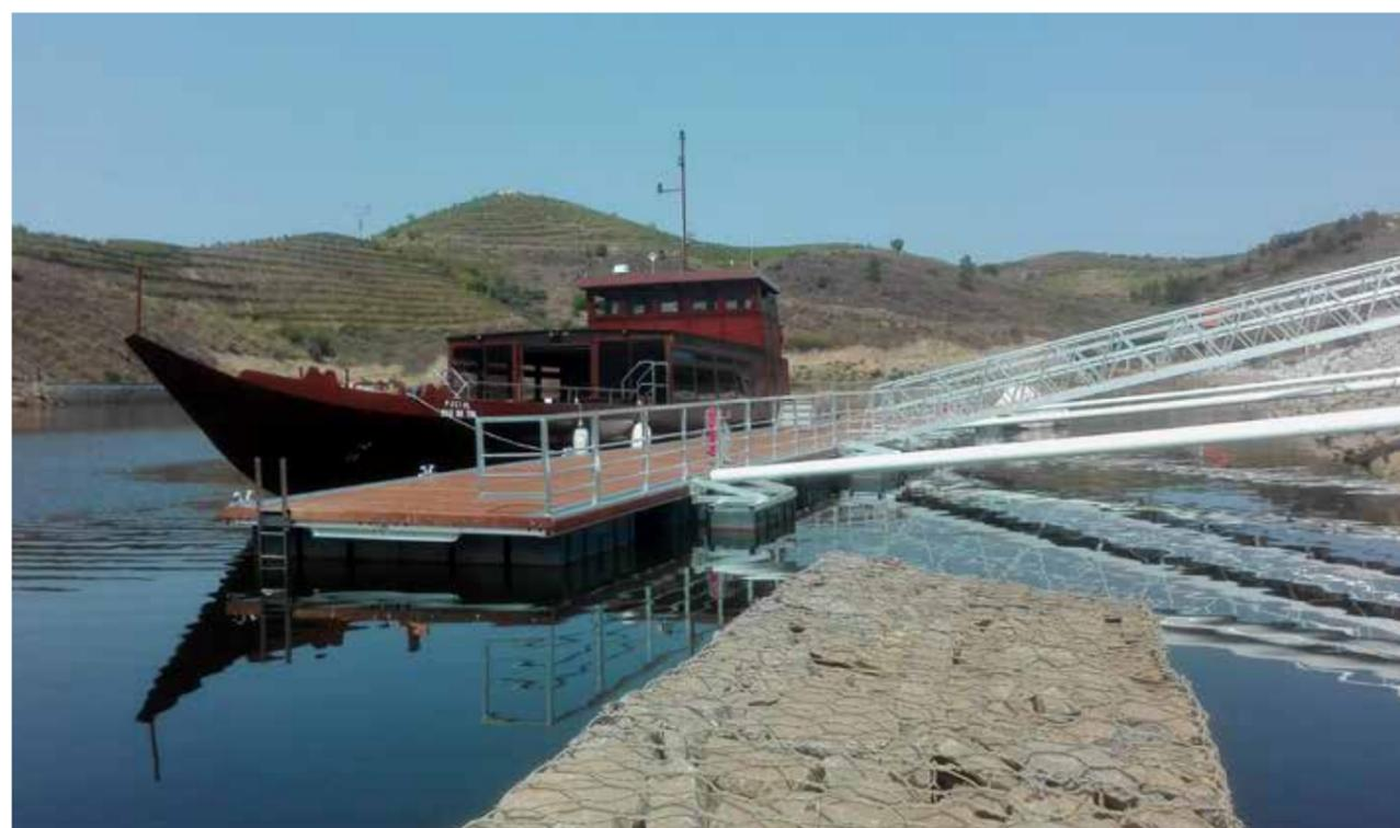
El sistema Faro HD está formado por equipamiento flotante con estructura reforzada con aleación de aluminio marítimo. Se utiliza para el amarre de embarcaciones en dársenas semiprotegidas en zonas agresivas donde la corrosión es un factor crítico.
